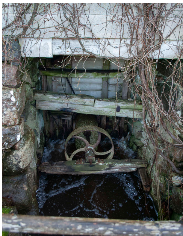
Vattenhjul under kvarnen.
