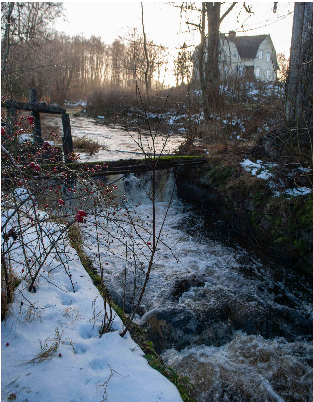
Den norra rännan förbi kvarnen med stenskodda kanter. Till vänster skimtar det som är kvar av dammluckan.
